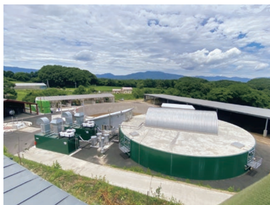
完成したメタンガスの発酵槽
